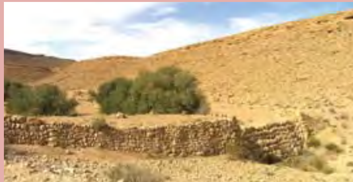
Construcción de terrazas para recuperar el agua y controlar el corrientes laminar sobre la tierra cerca de Tataouine, en el sur de Túnez.
