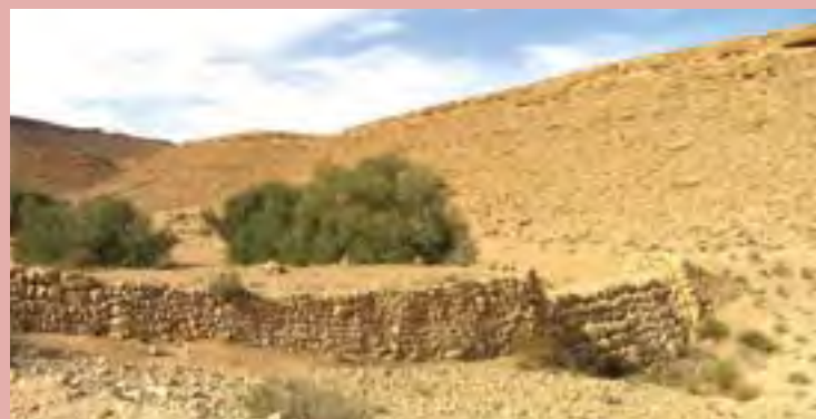
Construction traditionnelle de terrasses afin de capter l'eau et de contrôler le débit près de Tataouine, dans le sud de la Tunisie.
